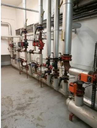
Figure 26. - Photos de la chaudière dans l'existant- Source : G-ON
