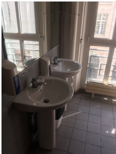
Figure 22. - Photos du revêtement de sol existant - Source : G-ON
