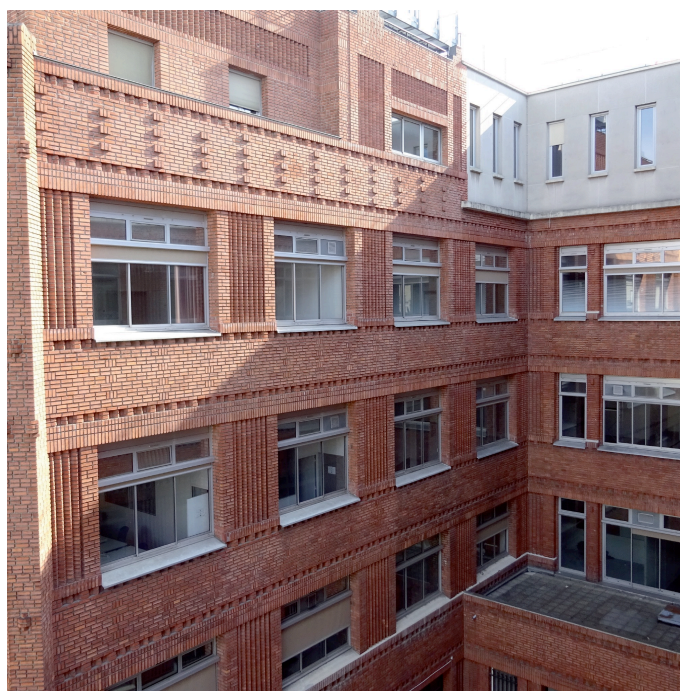
Figure 6. Vue bâtiment Édimbourg sur cour - Source : G-ON
