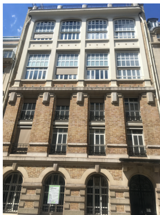
Figure 5 : Vue bâtiment Madrid-Source : G-ON
