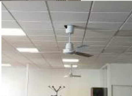
Figure 29. - Photos des émetteurs froid dans l'existant -Source : G-ON
