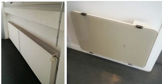
Figure 27. - Photos des émetteurs chaud dans l'existant -Source : G-ON
