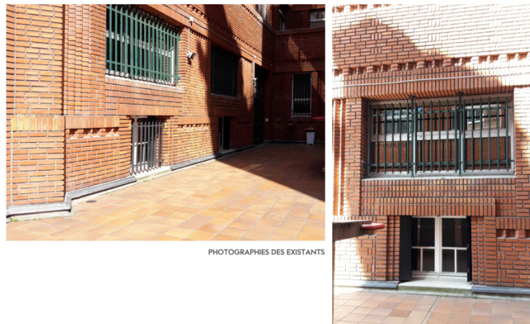
Figure 33. –Matériaux en brique à terre cuite dans l'existant -Source : Studio architecture
