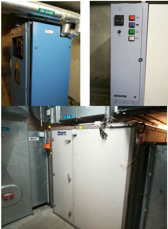
Figure 28. - Photos de production eau glacée dans l'existant -Source : G-ON
